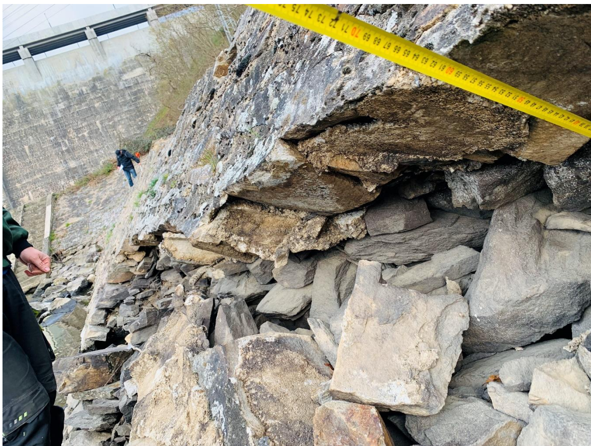
Obr. Nátrž v dlažbě o mocnosti 60 cm
