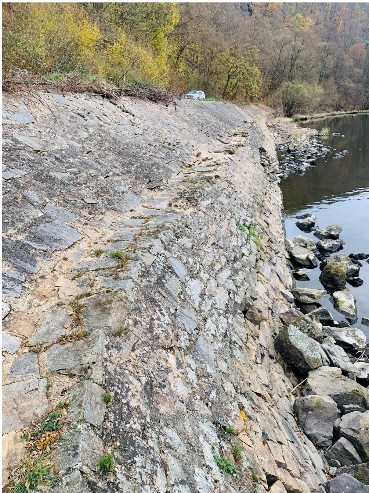
Obr. Viditelné poškození bermy
