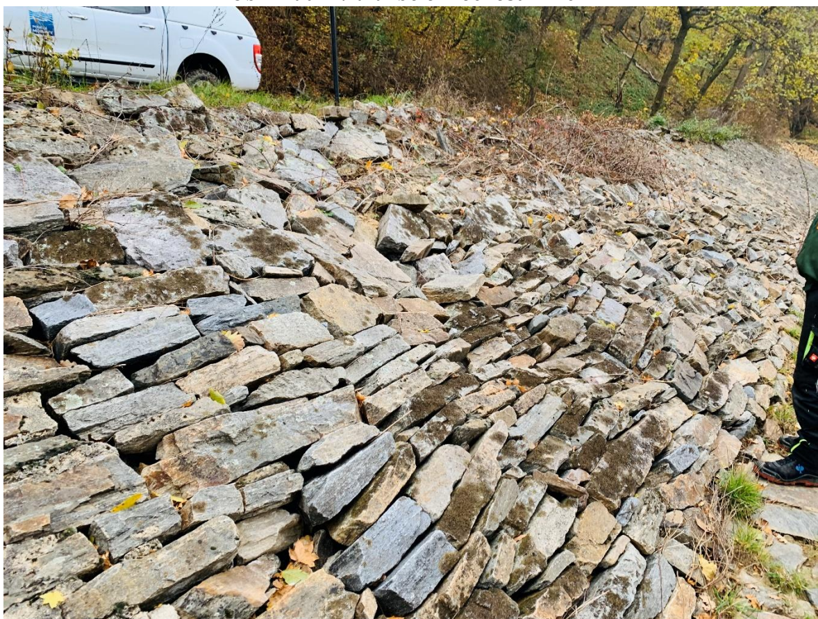
Obr. Detail ložení původního kamene na štět
