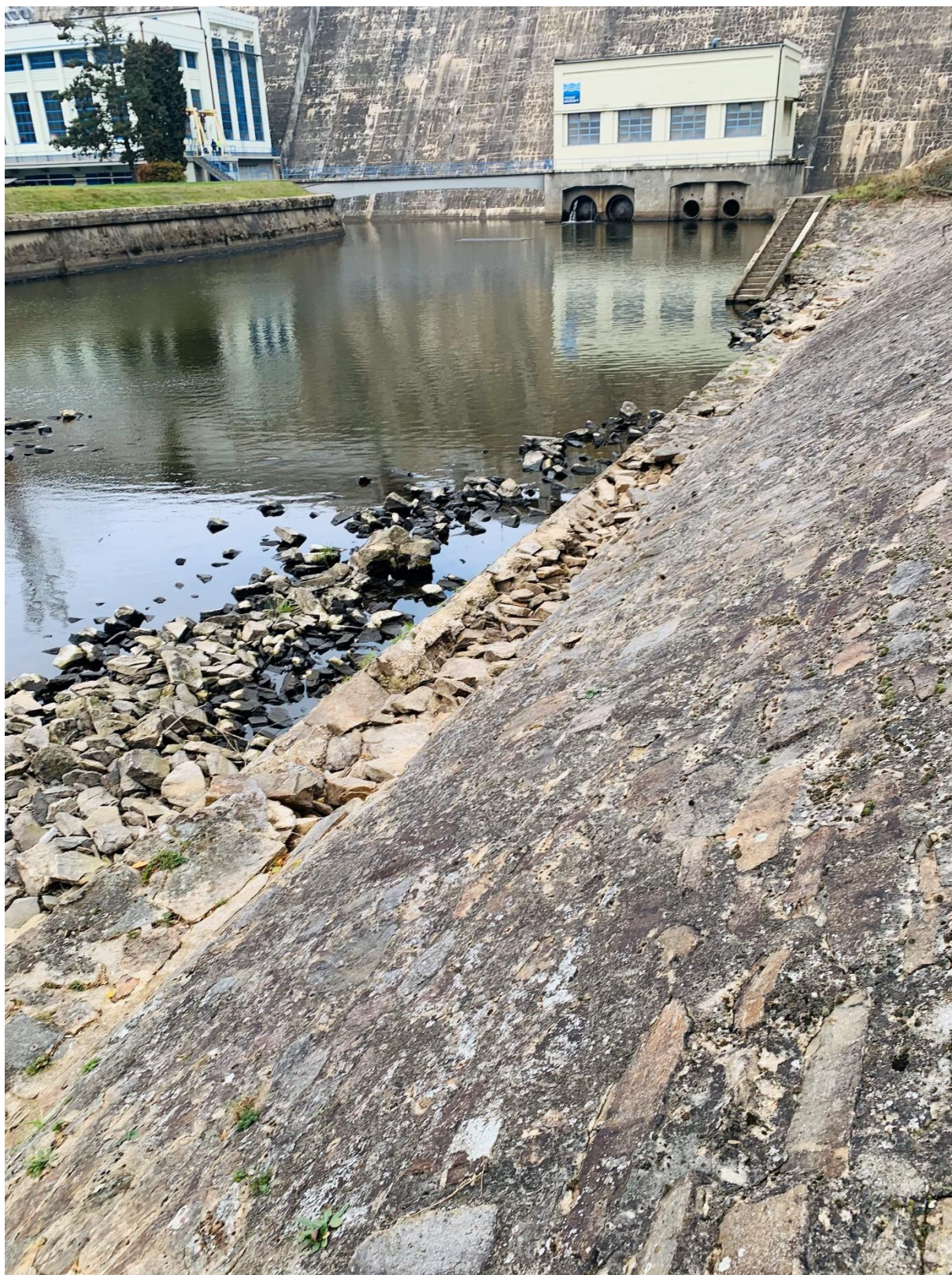
Obr. Viditelné poškození na LB, kameny sesunuty do toku, viditelné spárování
